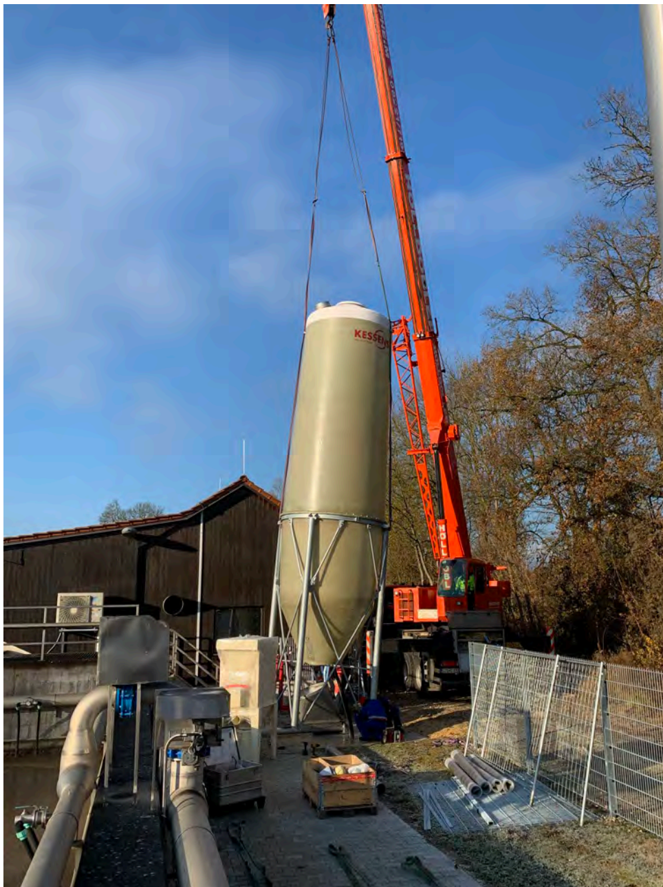
Aufbau Kreidedosieranlage
